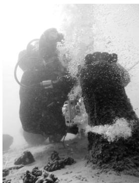
Holzproben, damit die Fachleute anhand der Jahresringe das Holzalter der Eichenpfähle und das Fälldatum bestimmen konnten. Hier kam eine pneumatische UW-Kettensäge zum Einsatz, was uns die Arbeit erheblich erleichterte.
